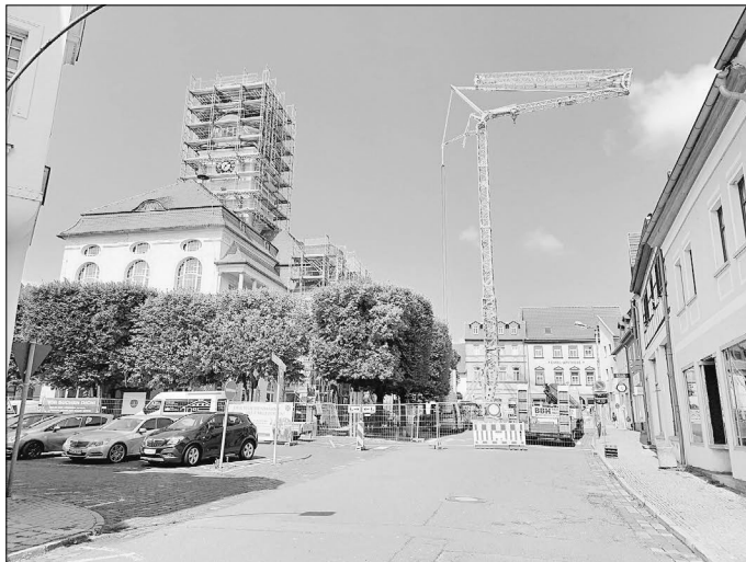
Hier wird der Kran noch aufgebaut - rechts zwischen Kran und Fußweg verläuft die Einbahnstraße
