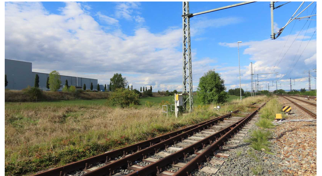
Einbauort Spiegelweiche für Gleisverlegung Quelle: Mitteldeutsche Baustoffe GmbH
